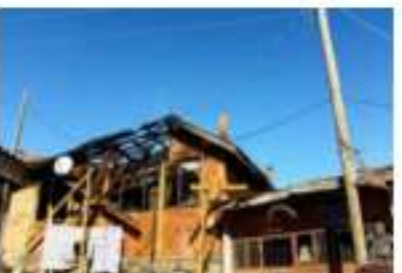
Bolu'da Ev Yangını
